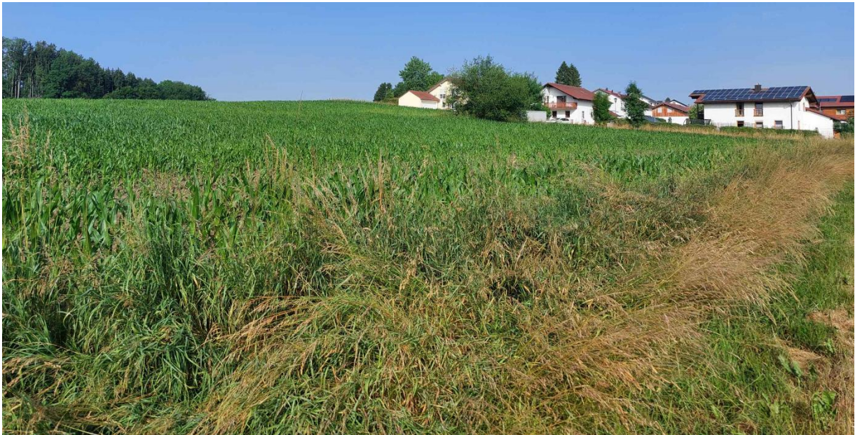
Abbildung 2: Blick von der Kreisstraße MÜ 25 auf das Baugebiet und die dahinter liegende Siedlung an welche angeschlossen werden soll
